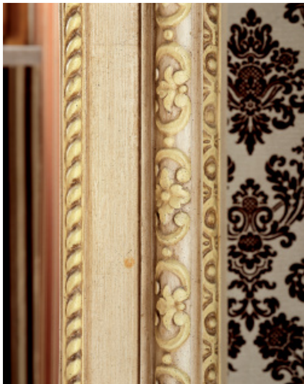
DEMONTE, PALAZZO DEL MUNICIPIO, NEL SALONE IN CUI AVEVANO LUOGO I RICEVIMENTI E I BALLI. DOMENICA 7 AGOSTO 2005, ORE 15,38
